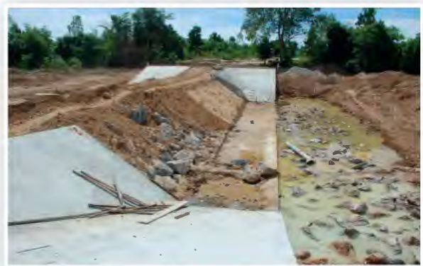
ฝายในลำห้วยสามพันนาม (กำลังก่อสร้าง)
