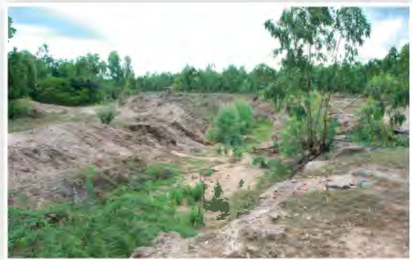
ทางซัดน้ำ จากบ่อบนไปบ่อล่าง
